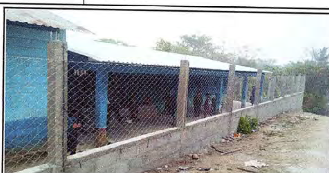
Foto 2: Realización del muro perimetral
