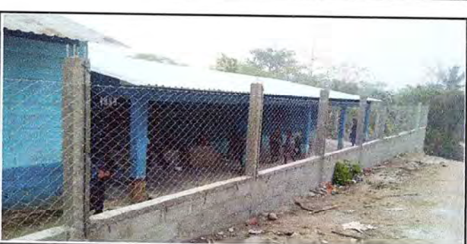
Foto 6: Colocación de maya a muro
