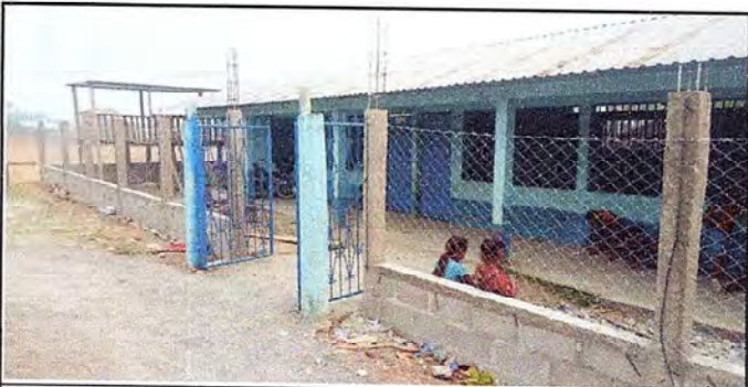
Foto 3: Colocación de Porton
