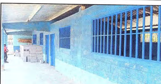
Foto 4: Colocación de balcones
