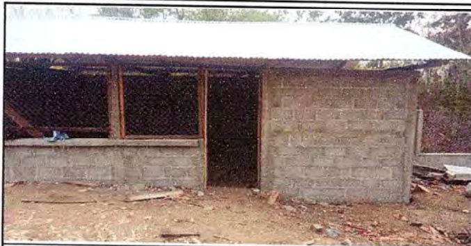
Foto 1: Reparación de la cocina.
