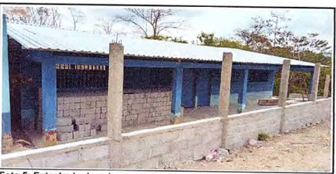
Foto 5: Entechado de aulas
